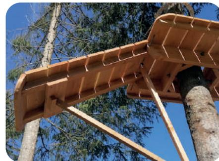
Avec une liaison articulée permettant de réduire les contraintes sur la plateforme et la pression sur le tronc.
